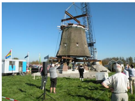
De verplaatsing van de molen.
