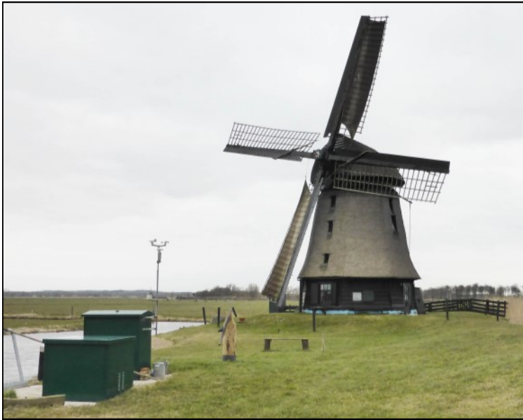
Figuur 2: De Wimmenummer molen, Egmond aan den Hoef, met gemaal. Omdat het gemaal een beperkte capaciteit heeft van ca. 12 mm/dag moet de molen zeer regelmatig bijspringen. Foto. R. V.
